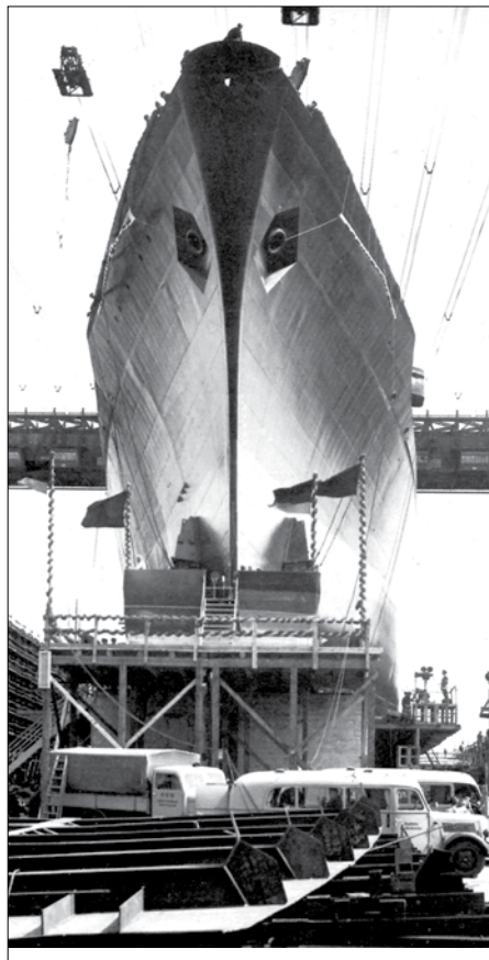
14. Januar 1956: Stapellauf der »Frieden«, des ersten in der DDR gebauten 10.000-Tonnen-Frachters.
